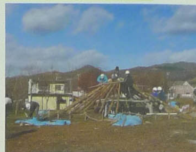
平成19年11月 竪穴住居（骨格復元）修復作業
